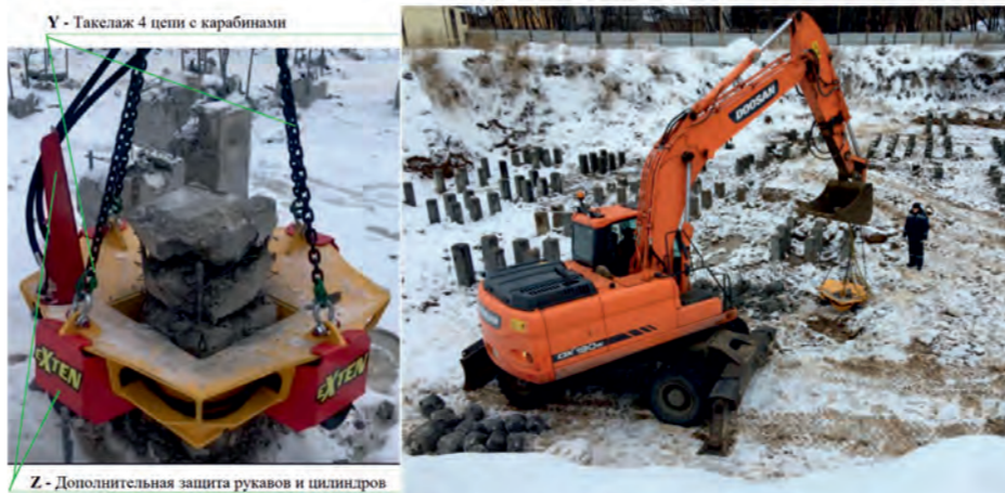
Z - Дополнительная защита рукaвov и цилиндров
